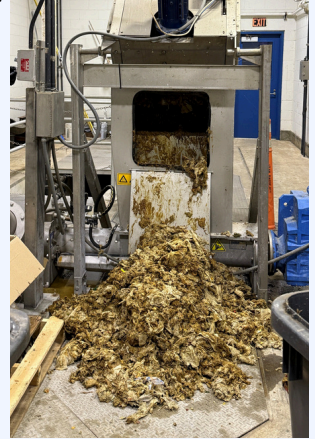
Atasco en la Planta de tratamiento de aguas residuales de Stayton por las toallitas
